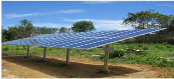
การติดตั้งแผงแสงอาทิตย์ทดแทนพลังงานไฟฟ้า
